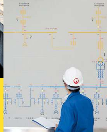
变电站一次系统模拟图
