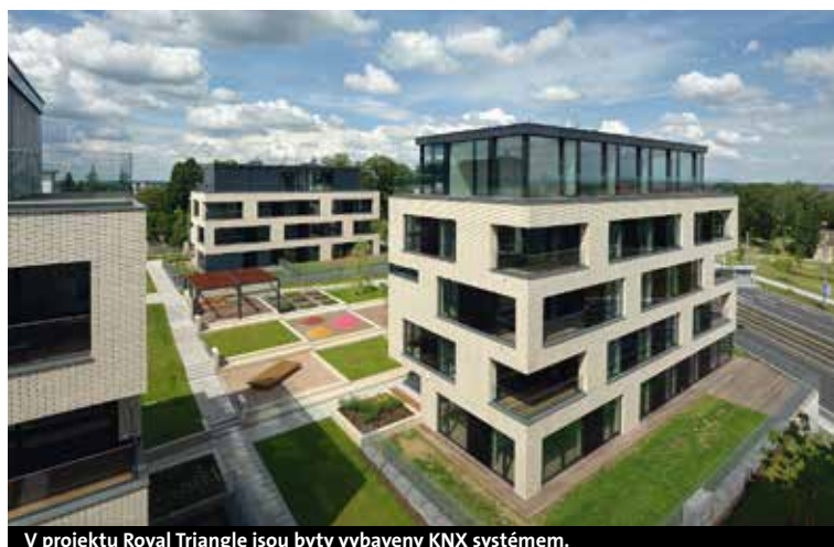
V projektu Royal Triangle jsou byty vybaveny KNX systémem.
