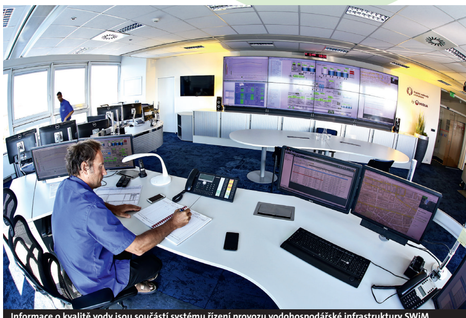
Informace o kvalitě vody jsou součástí systému řízení provozu vodohospodářské infrastruktury SWiM.
